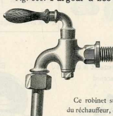
Fig. 516. Robinet de prise de vapeur
